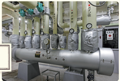
メインプラント 廃熱受入熱交換器
